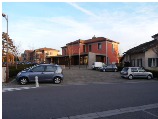
Stationnement derrière la mairie
