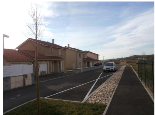
Ex de l'aménagement Les Ouyassières
